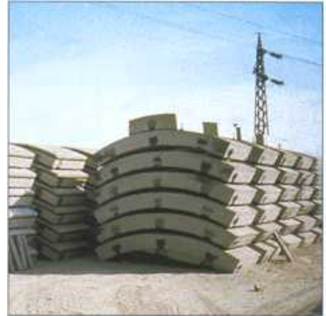
Horizontal storage (Metrosud).
